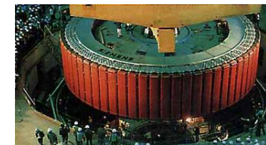
Synchrongenerator im Wasserkraftwerk Itaipu - Brasilien
