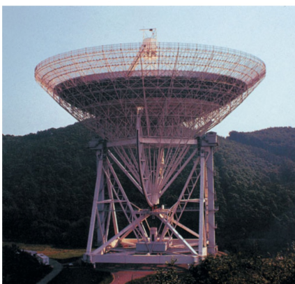
Abbildung 9.18 Radioteleskop Effelsberg in der Eifel. Der Durchmesser der Paraboloid-Antenne beträgt 100 m. Das ganze System kann um eine vertikale Achse rotieren. Das Paraboloid kann um eine horizontale Achse geneigt werden
