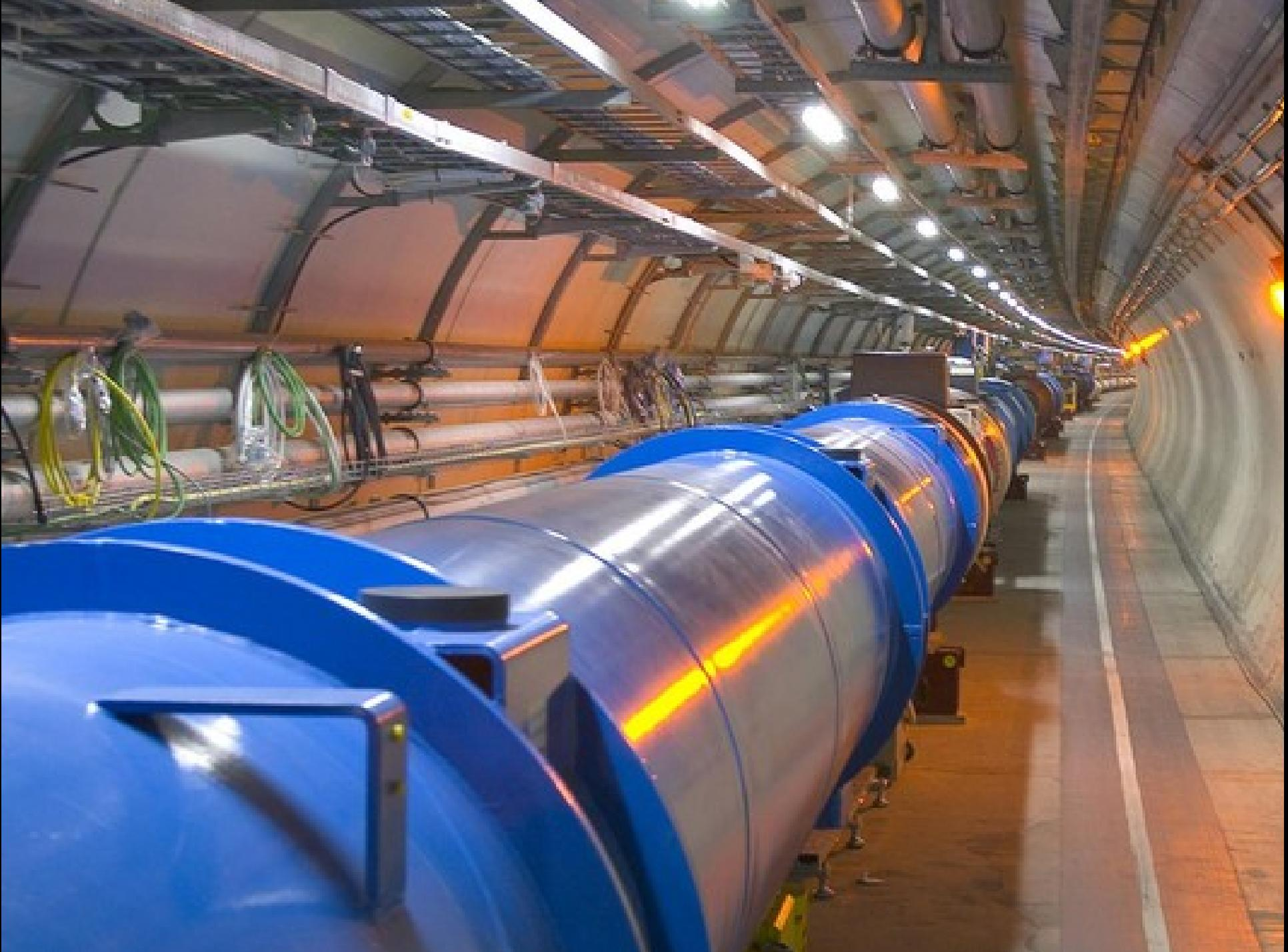
**LHC-Magnete sind kalt:  $-271^{\circ}\text{C}$**
